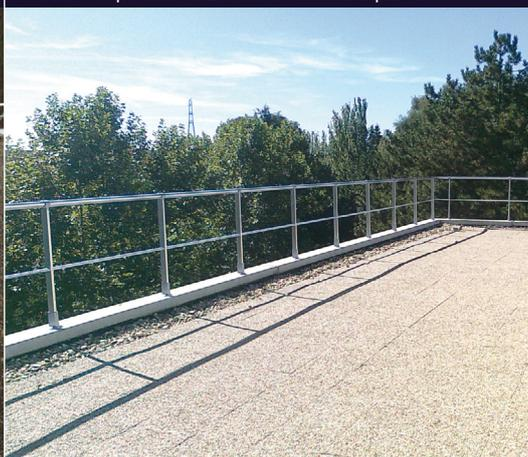
Garde-corps avec plinthe VECTACO® fixation à plat
